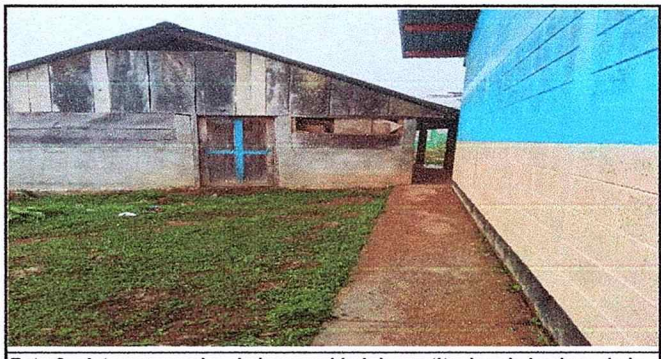
Foto 6: vista panorámica de la necesidad de sustitución de laminas de la cocina
